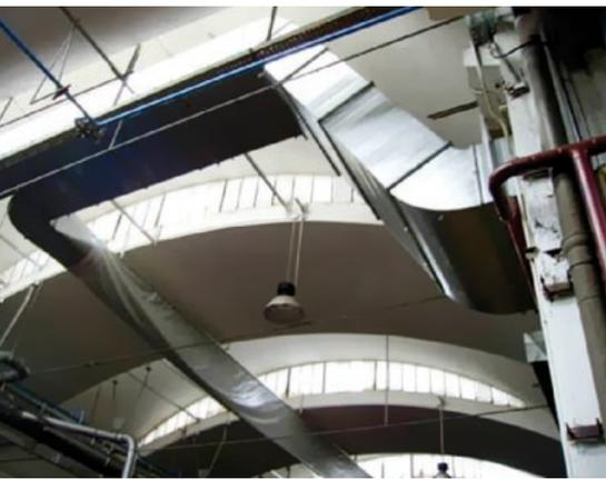
**Bild 17:** Hallenheizung mit Rückkühlleistung von 350 kW (Quelle Aichelin)
