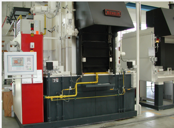
Bild 6: Mehrzweckkammerofen zur Wärmebehandlung von Wälzlager
