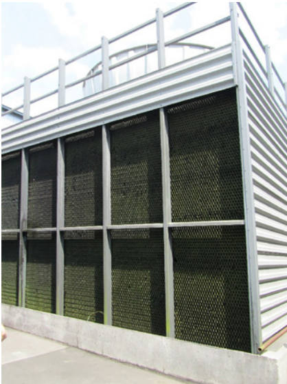
Bild 4: Biofilm- und Schmutzablagerung auf einer Kühlturmwabe
