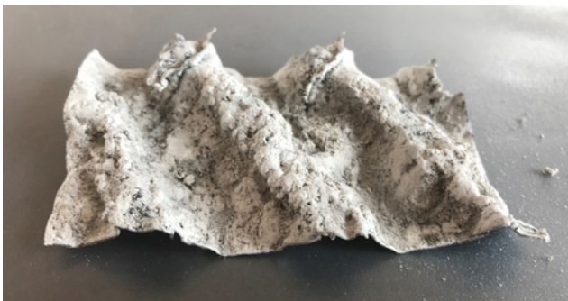
Bild 1: Ausschnitt einer Kühlturmwanne mit Härteablagerungen
